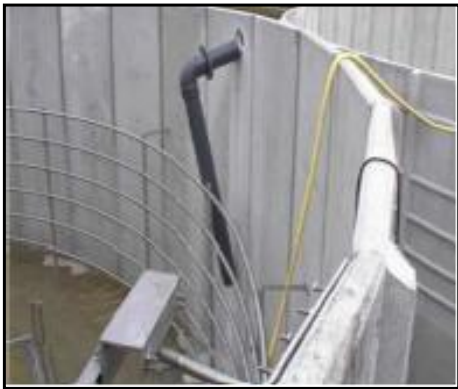
Ilustración 20. Ejemplo de sistema de calefacción de composite estratificado y de acero inoxidable.
